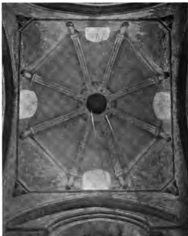
Fig. 135. — Coupole nervée sur tambour soutenu par trompes coniques à l'église de Nouaillé (Vienne).
